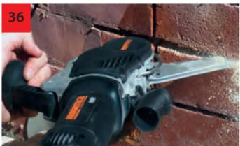
36 Neue Sägetechnologie ermöglicht besonders genaue Schnitte in Mauern.
